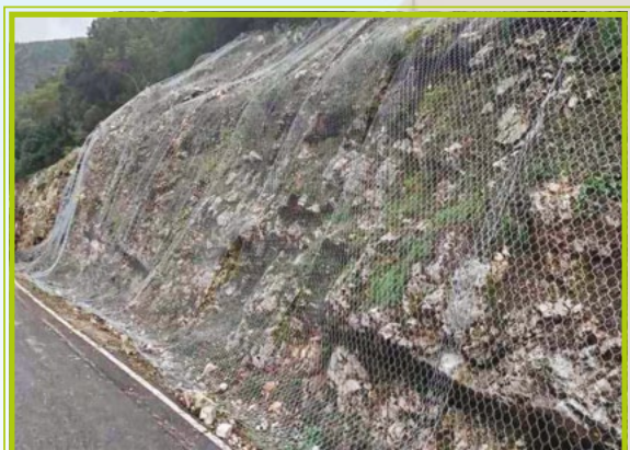
Εικόνα 12.3. Κάλυψη των πρανών με μεταλλικό πλέγμα
