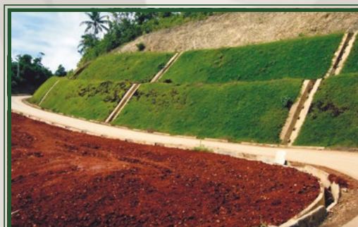
Εικόνα 12.4. Δημιουργία αναβαθμίδων και φύτευση σε πλαγιά
