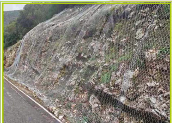
Εικόνα 12.3. Κάλυψη των πρανών με μεταλλικό πλέγμα
