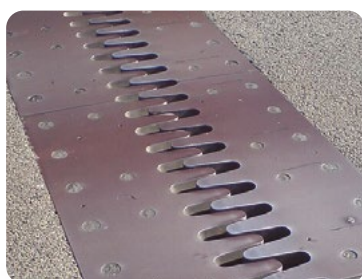
Στις γέφυρες υπάρχουν κατάλληλοι σύνδεσμοι ώστε κατά τη θερμική διαστολή ή συστολή της γέφυρας να μην προκαλείται πρόβλημα.
